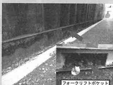
外壁・屋根・フレーム
