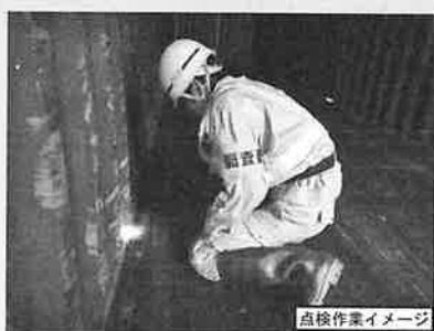
点検作業イメージ
